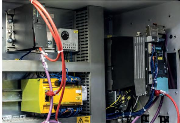
**03** Jeder der drei Rundtische wird über eine Siemens-S7-300 gesteuert, aus denen insgesamt rund 4000 Variablen auszulesen sind
