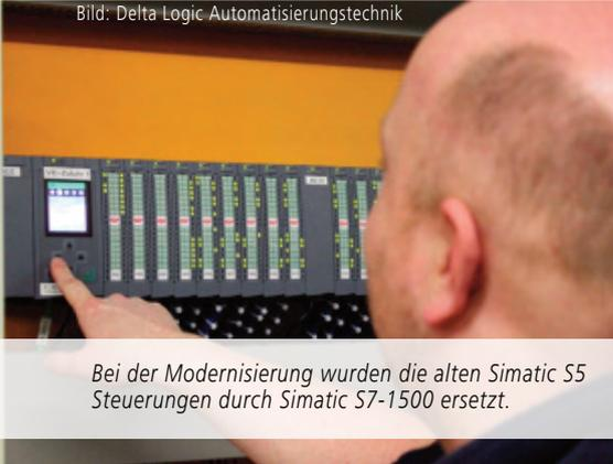
Bei der Modernisierung wurden die alten Simatic S5 Steuerungen durch Simatic S7-1500 ersetzt.
